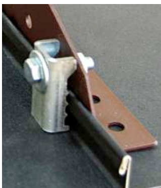
Кронштейн на двойном стоячем фальце (без затяжки)
