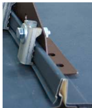
Кронштейн на Кликфальц® Pro (без затяжки)
